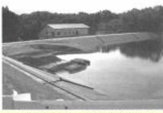
異常降水の継続による埋立地内部貯留水位の上昇
