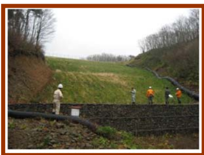
貯留構造物検査状況例
