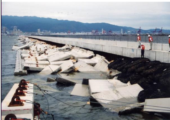
廃棄物埋立護岸は著しく被災したが、変形した遮水工は機能していた
