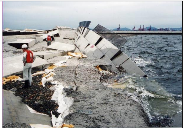
台風(強風・高潮)による波浪と越波で被災した処分場の例
