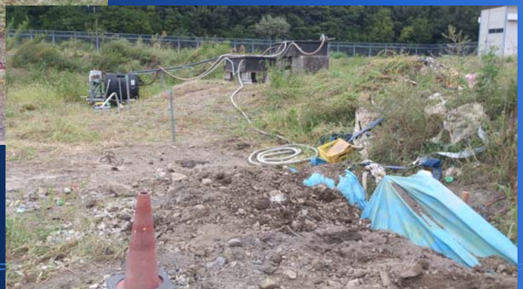
ブルーシートを敷設後、覆土。
