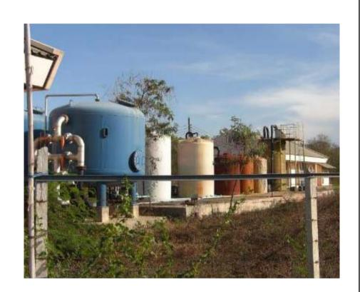
東南アジアの経済状況・技術力に適した 浸出水処理システム
