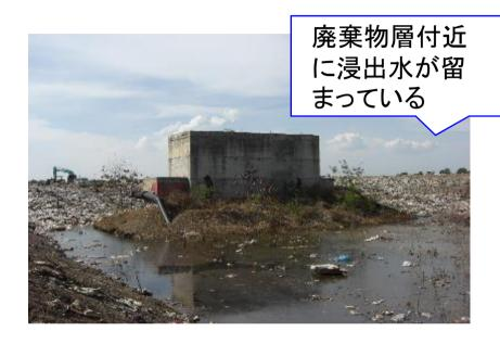
浸出水の処理・・・貯留池による処理
