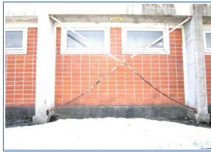
軸組ブレースの面内変形
