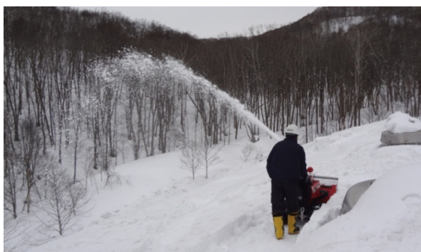
図 2-11 除雪機で除雪状況（屋根上）
