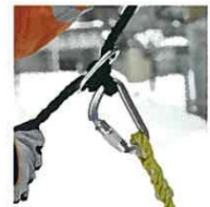
メガネ環を使って親綱に結束ポイントを作り、カラビナでアンカープレートと親綱を結束
