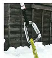
カラビナを使って、親綱とアンカープレートを直接に結束
