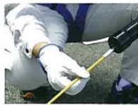
ラクポスティックの中にパイロットラインのワイヤを通して使います。
