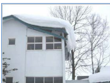
図 3-2 屋根上の落雪による影響
