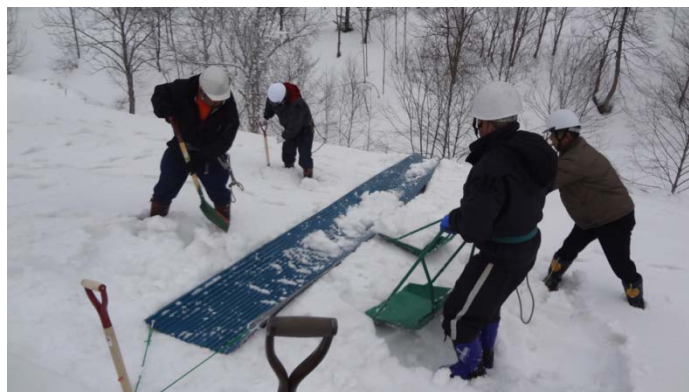
図 2-12 人力で除雪状況（屋根上）
