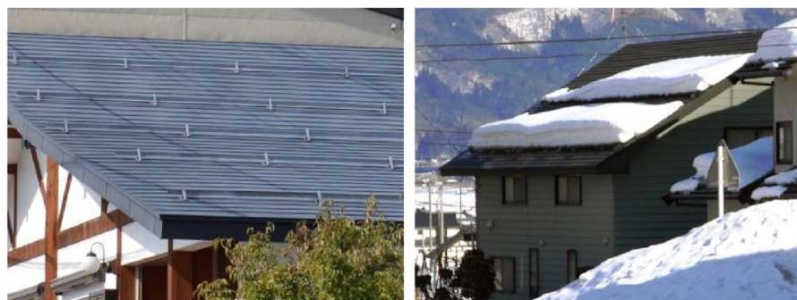
図 1-9 雪止め金具による落雪防止屋根
