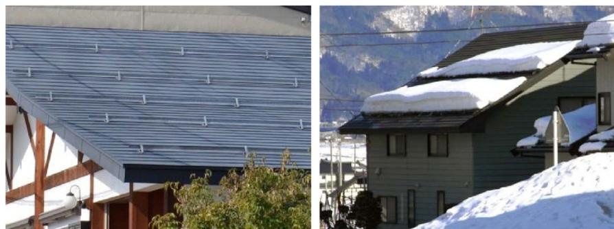
図 1-9 雪止め金具による落雪防止屋根
