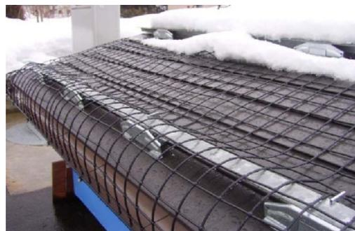
図 1-7 電熱装置を軒先のみ設置
