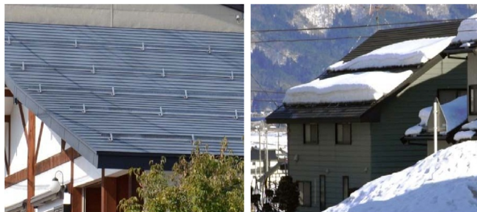
雪止め金具による落雪防止屋根
