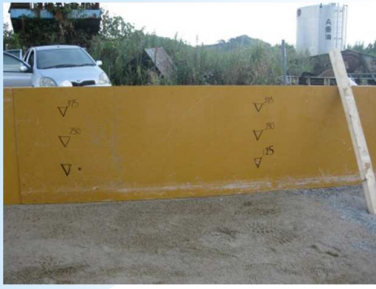
(a)木製型枠の設置
