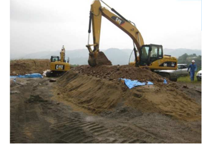
(f)保護土の敷設
