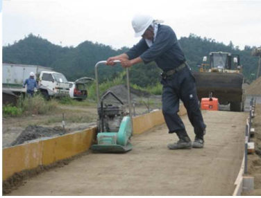
(d)BMS層の転圧
