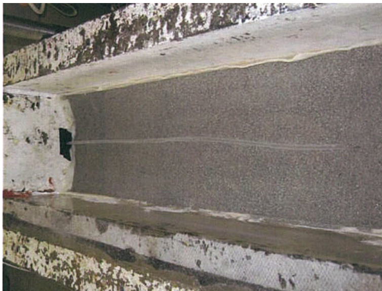
通水パイプ設置状況
