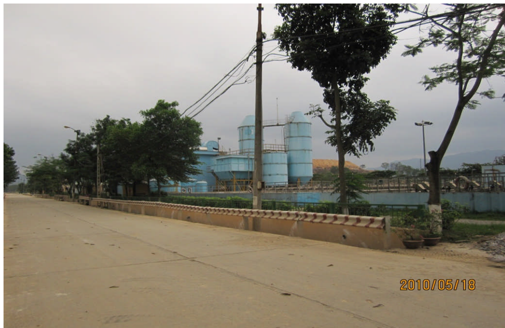
浸出水処理施設
