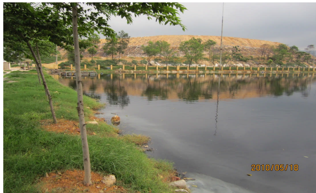
浸出水調整池
